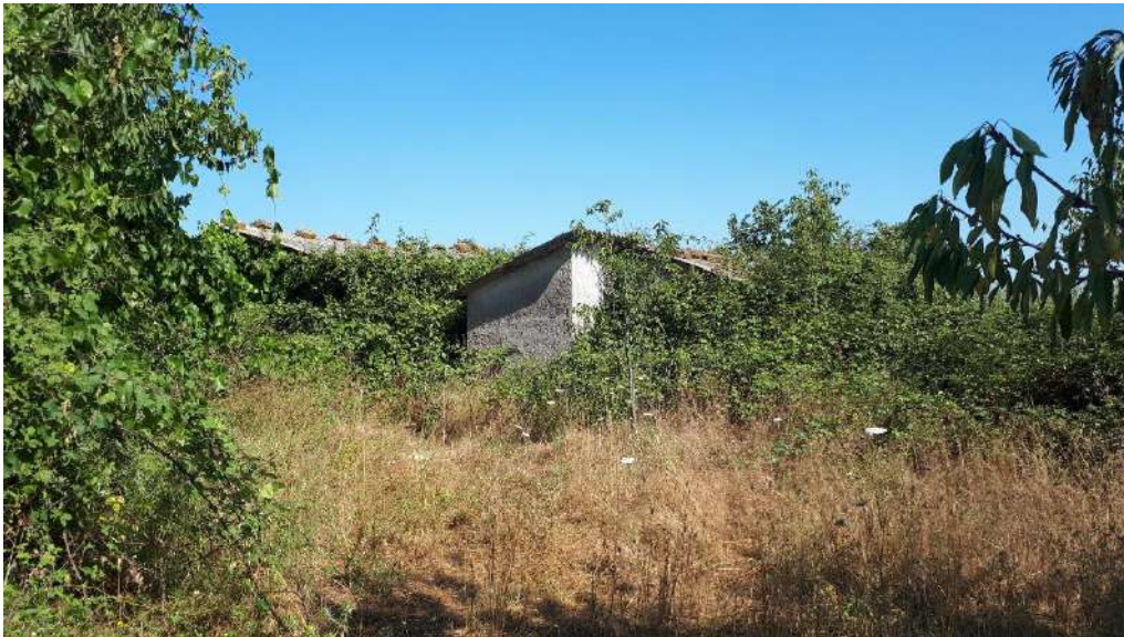
FABBRICATO P.LLA 207 E P.LLA 208
